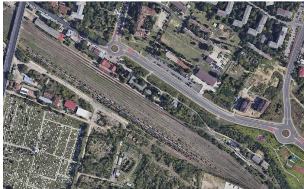
Zona adiacentă aproximativ paralelă cu Bdul Regele Ferdinand
